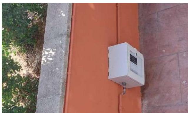
Figura 15. Control de agua y riego para evitar fugas.
